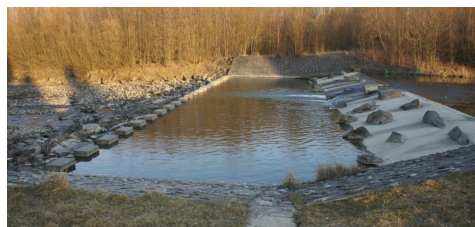
RYSUNEK 1. Bystrze na rzece Czarny Dunajec w miejscowości Czarny Dunajec FIGURE 1. The block ramp in the Czarny Dunajec river in Czarny Dunajec
