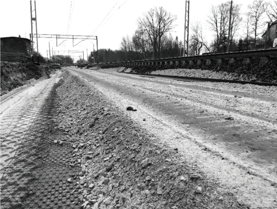
Rys. 11. Stabilizacja warstwy ochronnej w trakcie modernizacji linii LK 273
