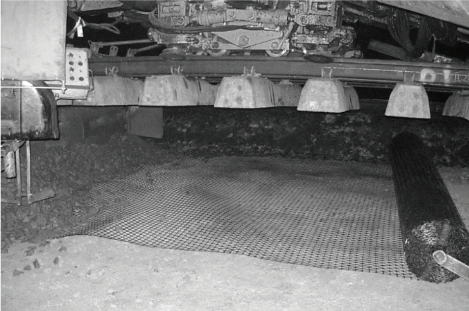
Rys. 13. Układanie georusztu Tensar TriAx za pomocą maszyny AHM
