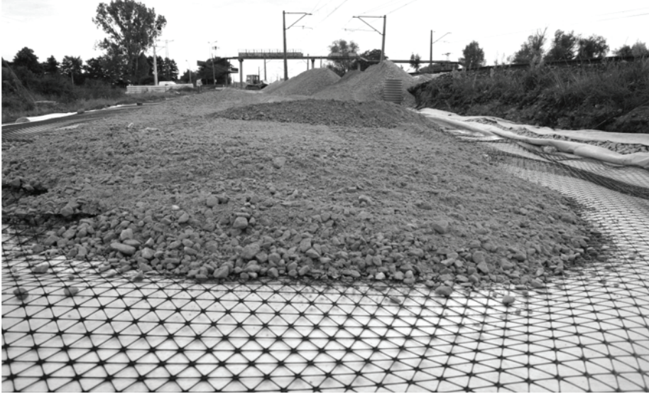
Rys. 10. Układanie pierwszej warstwy georusztu trójosiowego w trakcie modernizacji linii E65 na obszarze LCS Gdańsk
