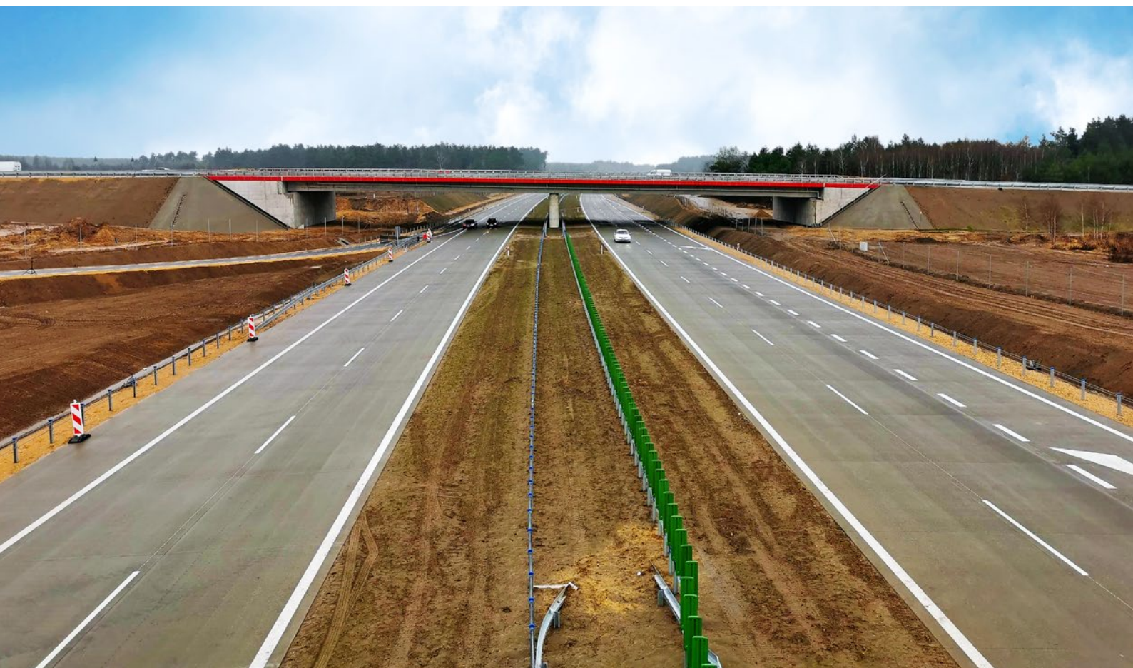
Autostrada A1, obwodnica Częstochowy, fot. Budimex SA
