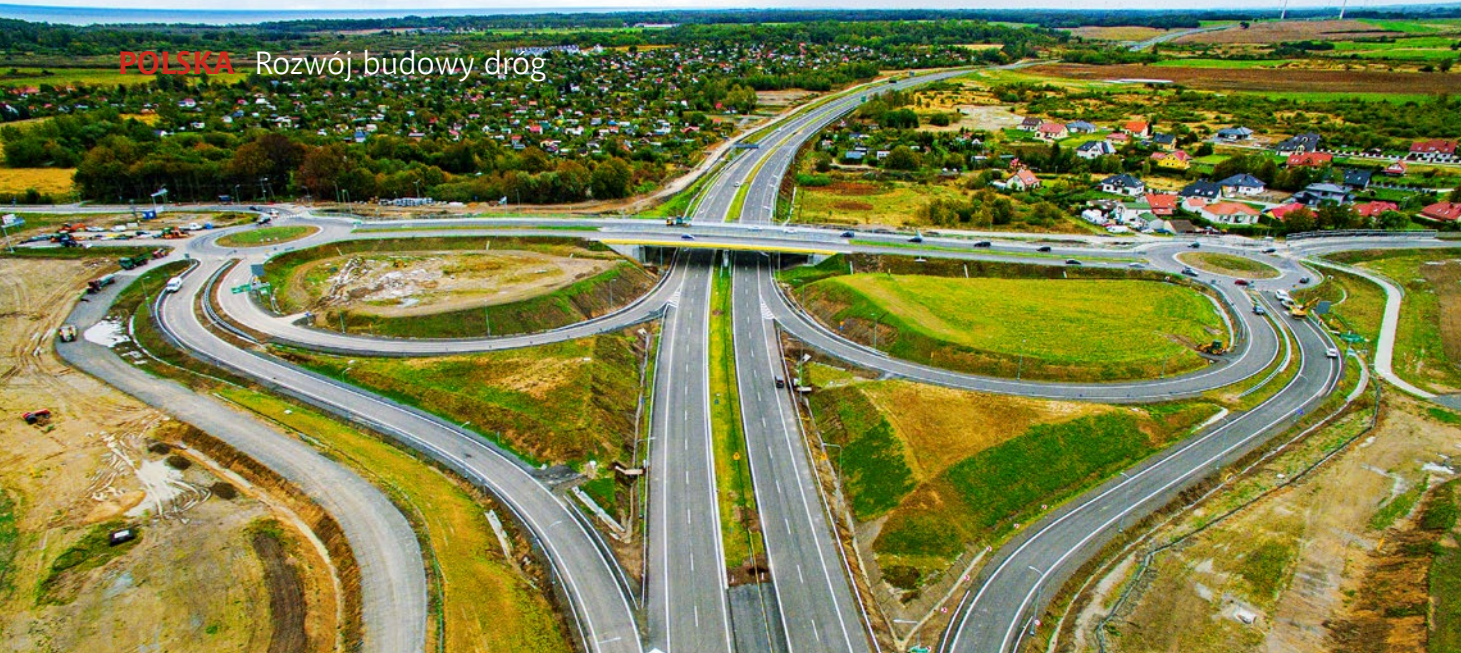
S6, Kołobrzeg – Ustronie Morskie, obwodnica Koszalina i Sianowa, fot. PORR SA
