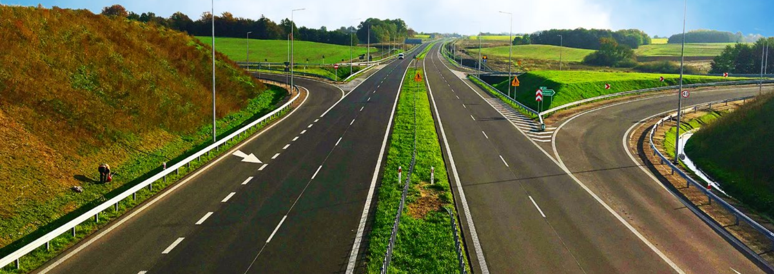
Droga ekspresowa S6, fot. Strabag Sp. z o.o.
