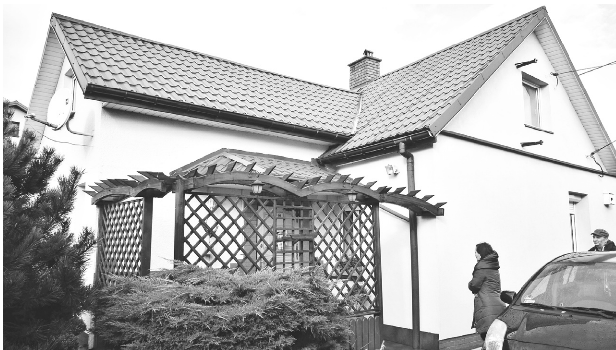
Ryc. 2. Dom z polan opałowych przy ul. Sikorskiego w Ostrowi Mazowieckiej, widok od strony podwórka; fot. A. Dobrońska, 2017 Fig. 2. A cordwood-constructed house in Ostrów Mazowiecka, Sikorskiego St. (a court view); photo by A. Dobrońska, 2017
