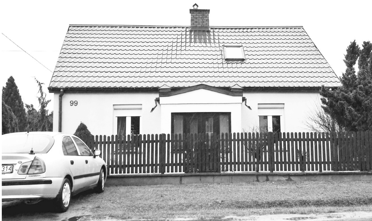
Ryc. 1. Dom z polan opałowych przy ul. Sikorskiego w Ostrowi Mazowieckiej, widok od strony ulicy. Fot. A. Dobrońska, 2017 Fig. 1. A cordwood-constructed house in Ostrów Mazowiecka, Sikorskiego St.; photo by A. Dobrońska, 2017
