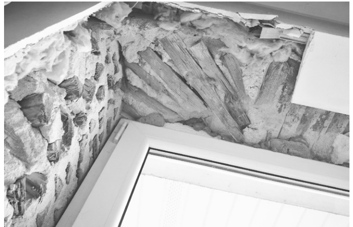
Ryc. 4. Widok na polana opałowe w niezastłoniętej jeszcze ścianie; fot. A. Dobrońska, 2017
