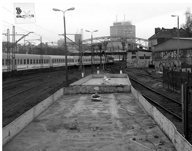
Rys. 1. Przyczepy PWM-15 z trzema odbiornikami Leica systemu 1200 SmartRover podczas przejazdu na szlaku Gdańsk Główny – Gdańsk Zaspas Towarowa
