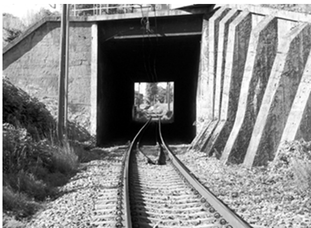
Rys. 2. Wiadukt kolejowy nad linią nr 227, widoczne łuki odwrotne
