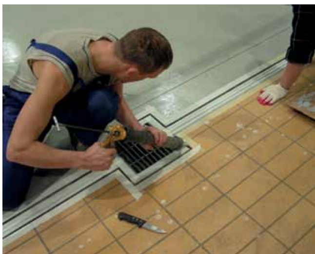
Rys. 7. Wypełnianie szczelin dylatacyjnych poliuretanową masą elastyczną
