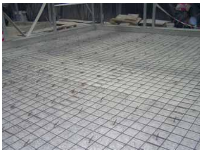
Rys. 4. Siatka zbrojeniowa ustabilizowana na kotwach stalowych
