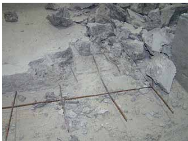
Rys. 2. Siatka zbrojeniowa ułożona bezpośrednio na podłożu
