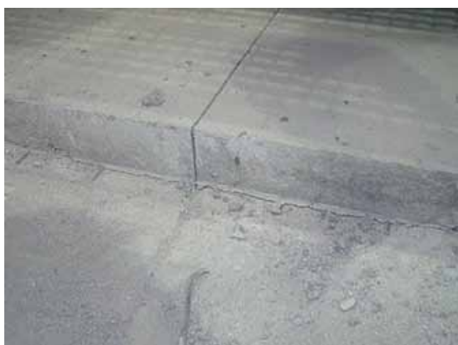
Rys. 3. Widok fragmentu nadbetonu
