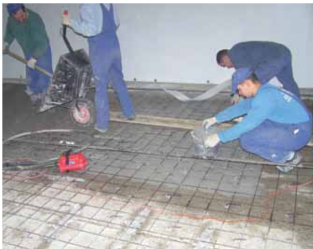
Rys. 5. Układanie mieszanki betonowej na świeżą warstwę mostkującą
