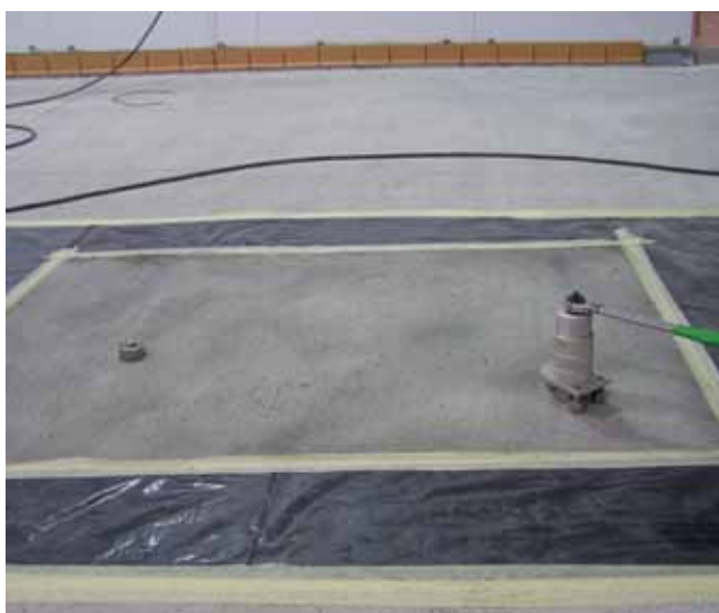
Rys. 6. Wykonanie próby przyczepności metodą pull-off preparatu gruntującego do podłoża
