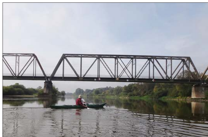
Fot. 9. Most kolejowy w Wyszkwie
