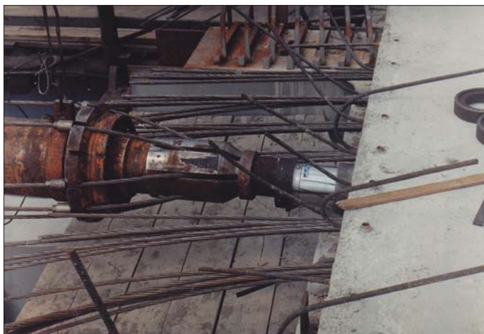
Fot. 6. Sprężanie płyty pomostu
