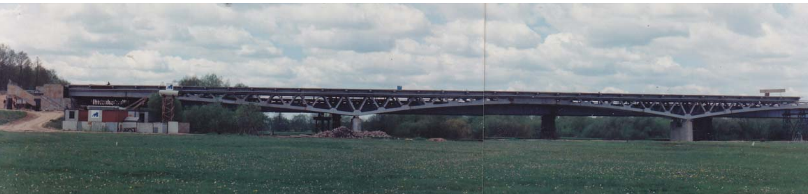
Widok mostu w końcowej fazie scalania dźwigarów
