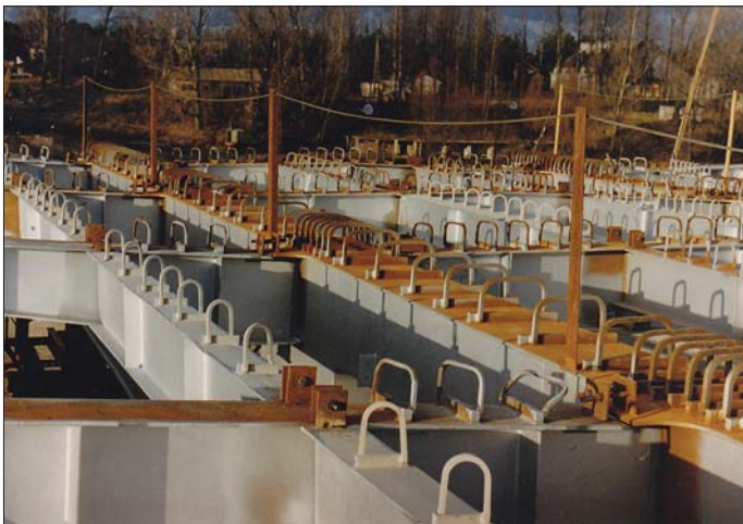
Fot. 3. Łączniki zespolenia dźwigarów stalowych z betonową płytą pomostu
