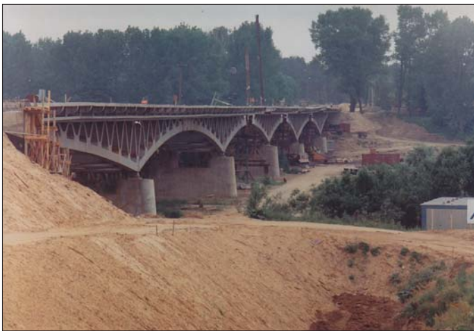
Fot. 4. Scalanie kolejnych przęseł
