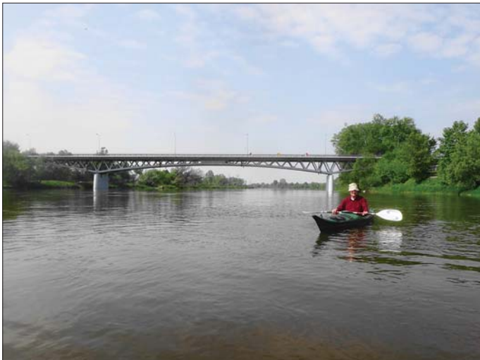
Fot. 1. Nadwodne przesłono mostu w Broku
