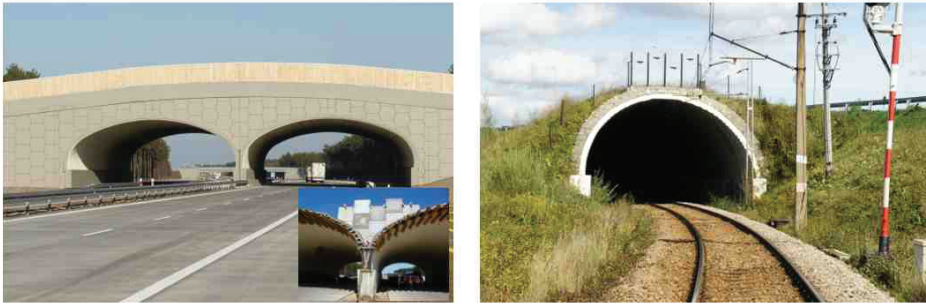
Rys. 2. Przykładowe konstrukcje gruntowo-powłokowe z blach falistych zrealizowane w ostatnich latach. Eko-most nad autostradą A2 (strona lewa). Tunel kolejowy na południu Polski (strona prawa)
