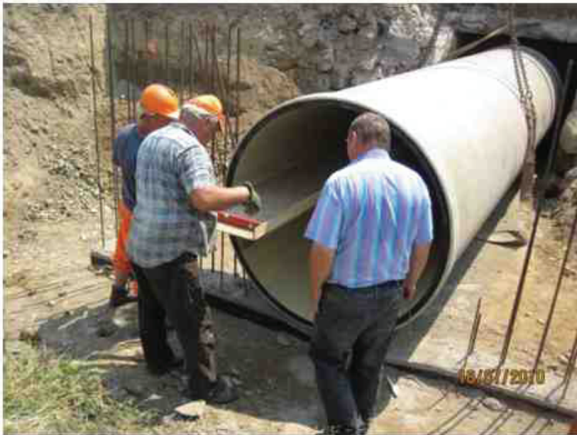
Rys. 8. Montaż konstrukcji przejścia zwierząt o konstrukcji zespolonej wykonywanego w technologii CC-GRP z widoczną jednostronną półką dla zwierząt {11}
