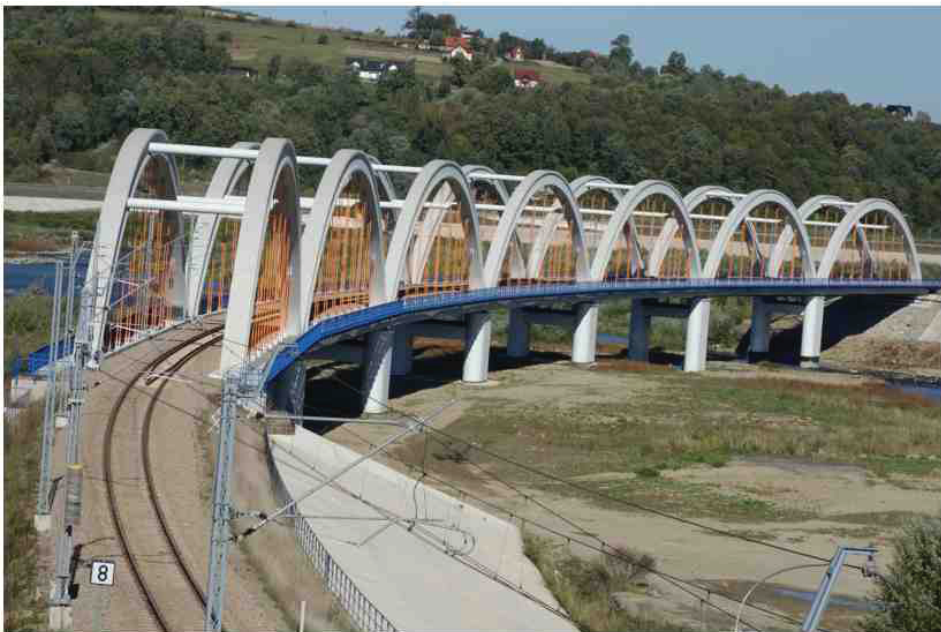
Rys. 3. Przykładowa konstrukcja kolejowego mostu łukowego pełniącego również funkcję ekologiczną (fot. A. Wysokowski)
