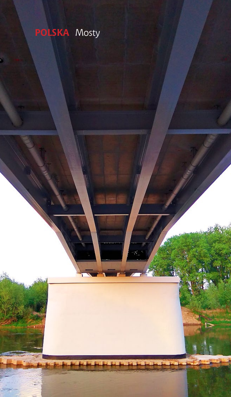
Ryc. 4. Widok konstrukcji od spodu na podporę pośrednią przęsła nurtowego (autor Mateusz Dutko, https://www.skyscrapercity.com )
