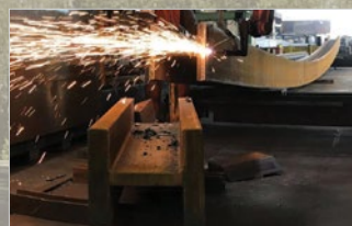
Prace spawalnicze, np. przygotowanie styków profili JUMBO
