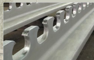
Prace antykorozyjne, np. metalizacja natryskowa
