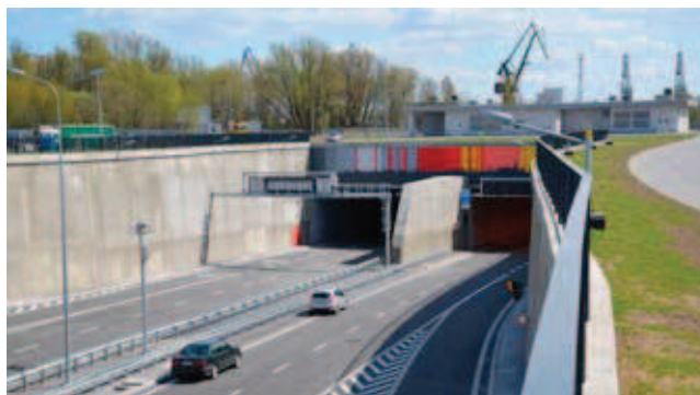
Wjazd i wyjazd z tunelu. W głębi budynek Centrum Zarządzania Tunelem
