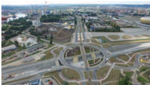
Budowa węzła Marynarki Polskiej
