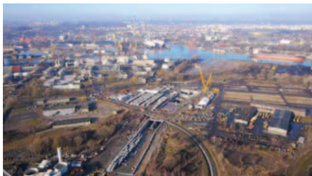
Budowa tunelu od strony węzła Ku Ujściu
