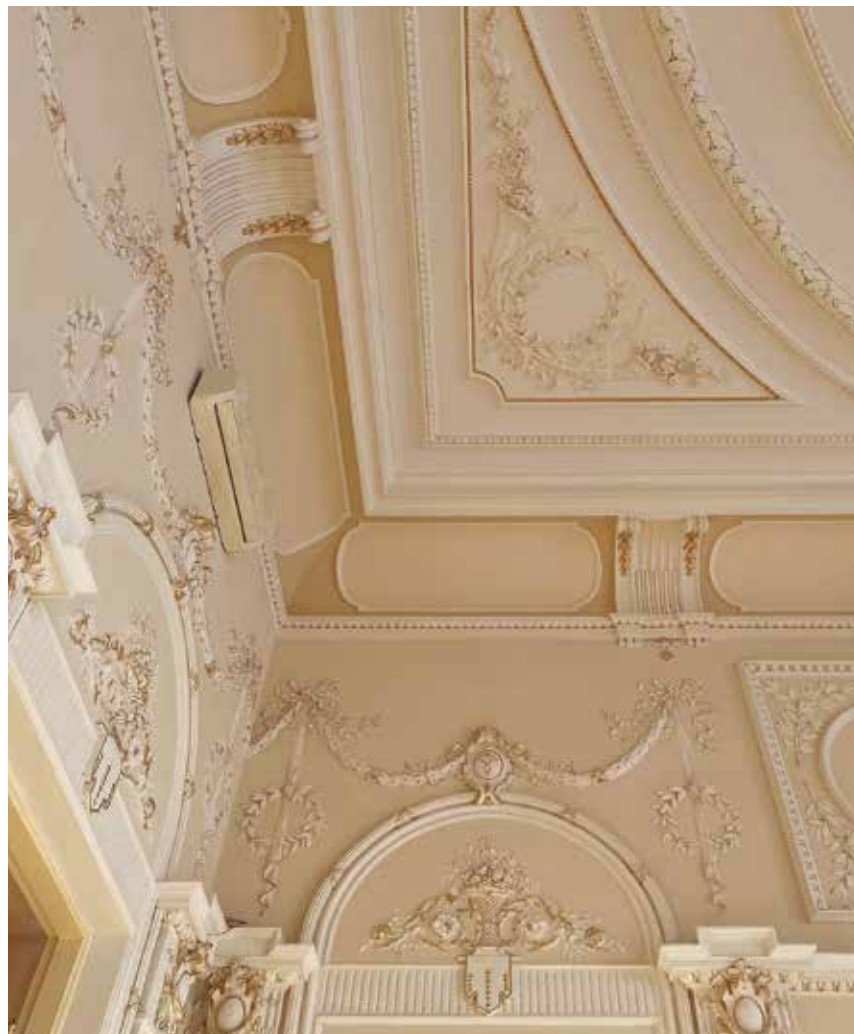
Fot. 4. Sufit w sali teatralno-kinowej – stan po rewitalizacji; źródło: fot. własna
