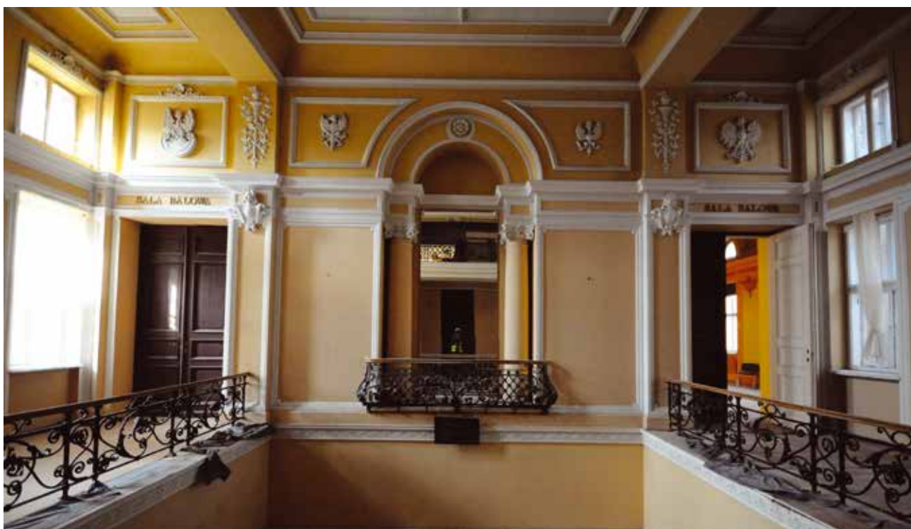
Fot. 2. Foyer przed salą teatralno-kinową – stan przed rozpoczęciem prac rewitalizacyjnych; źródło: [5]
