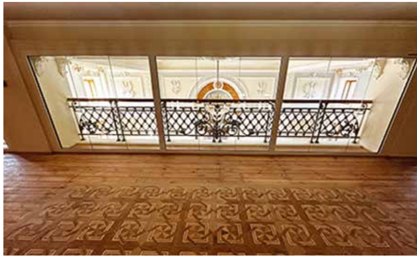
Fot. 7. Tafle parkietu z sali teatralno-kinowej wmontowane w drewnianą podłogę; źródło: fot. własna
