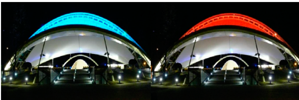
Fot. 2. Amfiteatr w Wiśle. Zmienna, wielobarwna iluminacja. Podświetlenie listwami LED płaszczyzny napiętego zadaszenia. Zadanie stanowi formę ekranu o dużych możliwościach dla prezentacji multimedialnych, np. można wyświetlać obrazy, filmy, informacje, reklamy itp.
