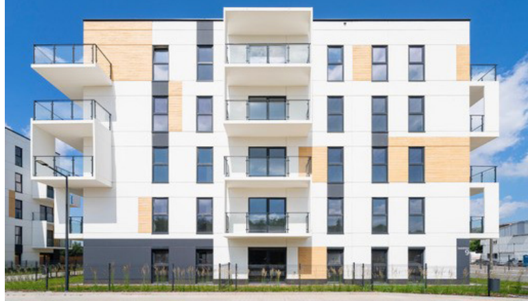
II 7. Widok elewacji budynku prefabrykowanego wielorodzinnego przy ul. Jasielskiej w Poznaniu, źródło: materiały przedsiębiorstwa Pekabex S.A. III. 7. View of the elevation of a multi-family residential building at ul. Jasielska in Poznan, source: materials thanks to courtesy of Pekabex S.A.
