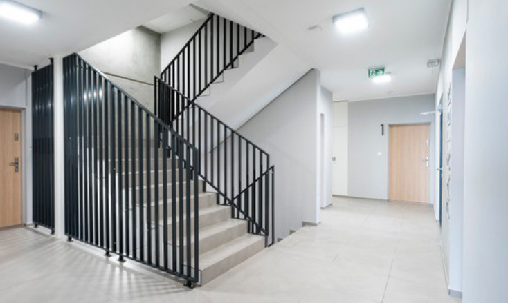
II. 6. Widok wnętrza części poza mieszkaniami w budynku przy ul. Jasielskiej w Poznaniu, źródło: materiały przedsiębiorstwa Pekabex S.A. III. 6. View of building interior, outside of flats, at ul. Jasielska in Poznan, source: materials thanks to courtesy of Pekabex S.A.
