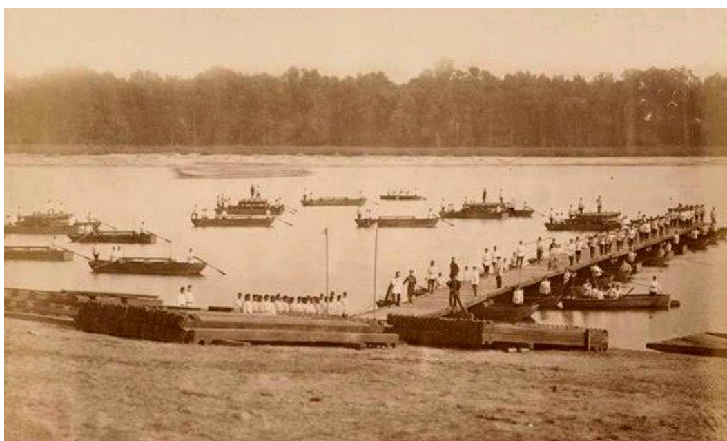
Rys. 2. Budowa mostu pontonowego pod Neogeorgijewskiem podczas ćwiczeń wojskowych w 1884 roku [14]
