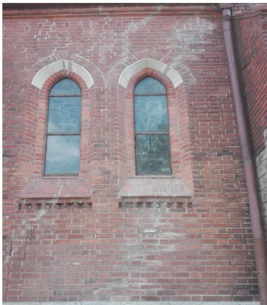
Rys. 13. Remont zewnętrznej ściany Fig. 13. Renovation of the external wall
