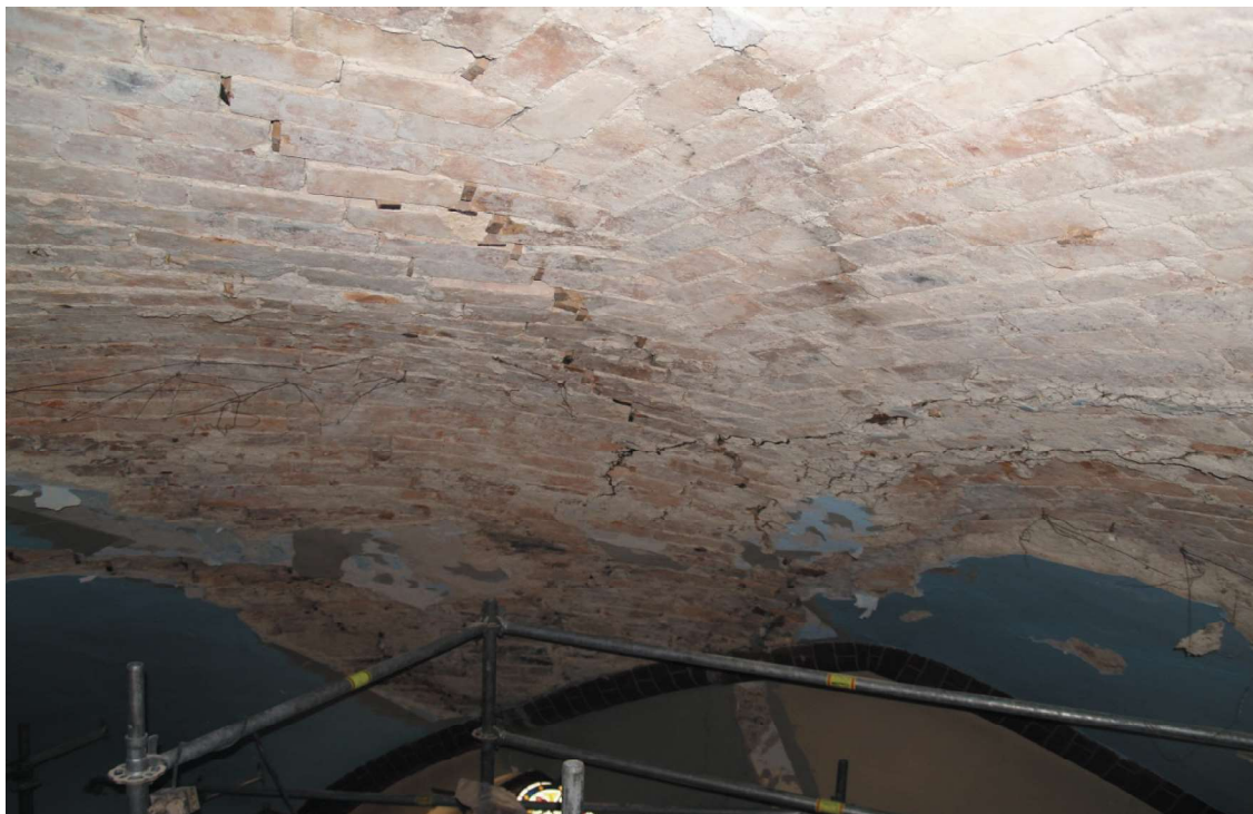
Rys. 11. Zdjęcie spękanego pierwszego pola sklepionego od strony wieży kościoła św. Wawrzyńca (2017r.) Fig. 11. A photo of the cracked first vaulted field from the tower of St. Lawrence Church
