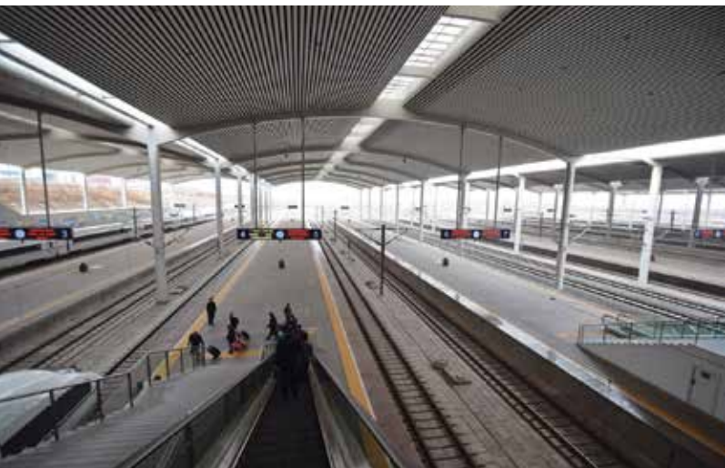
Dworzec Zachodni w Harbinie, Chiny (1.01.2014 r.) fot. Baycrest / © Wikimedia Commons
