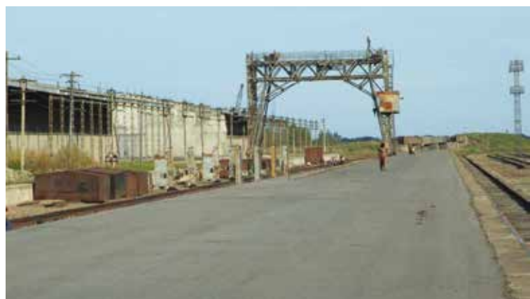
Podnośniki Kutruffa na stacji granicznej KSR / RZD Tumangang, Korea Płn. (8.02.2009 r.) fot. H. Uttenhaler
