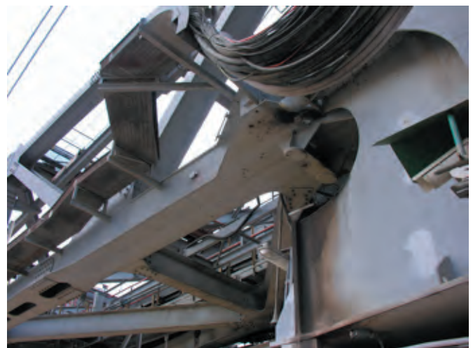
Rys. 10. Przykłady rozmieszczenia punktów pomiarowych na konstrukcji nośnej badanej koparki Fig. 10. Examples of the measurement points distribution on the tested excavator load bearing structure
