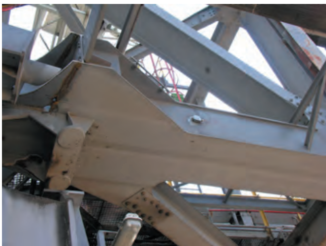
Rys. 9. Przykłady rozmieszczenia punktów pomiarowych na konstrukcji nośnej badanej koparki Fig. 9. Examples of the measurement points distribution on the tested excavator load bearing structure
