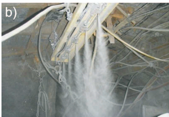
Rys.21. Powietrzno-wodne urządzenia do zraszania przesypów: a) zraszacz przesypów Bryza-1200, b) system zraszania VIRGA [14]
