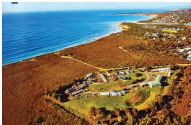
Ryc. 4. Realizacja projektu wymiany kanału kanalizacyjnego w parku narodowym nad oceanem
