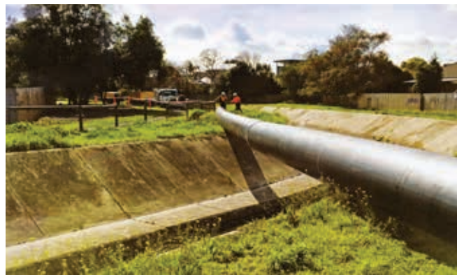
Ryc. 7. Rura polietylenowa DN 800 zastępująca istniejący kanał żelbetowy, już wcześniej poddany bezwykopowej rehabilitacji
