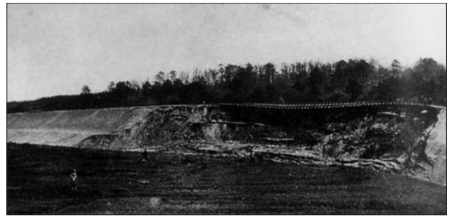
Ryc. 5. Najstarsze osuwisko antropogeniczne na obszarze Gdyni zlokalizowane w obrębie nasypu kolejowego w Wielkim Kacku; zdjęcie z 1930 r. (Gawek i in., 1996)
