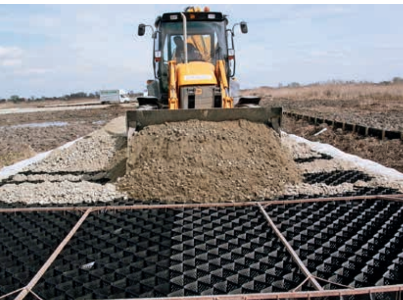
Ryc. 5. Budowa drogi technologicznej we Wrocławiu z wykorzystaniem geokraty GEOMAXX®, fot. Geo Globe Polska
