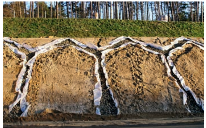
Ryc. 2. Geowłóknina TYPAR SF, drenaż na obwodnicy Gorzowa Wilkp., fot. GRILTX Polska
