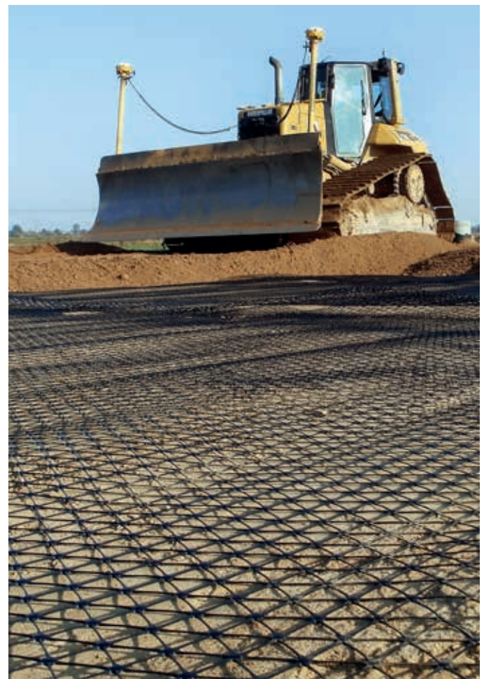
Ryc. 3. Zastosowanie georusztu Tensor® TriAx®, Południowa Obwodnica Gdańska, fot. Tensor International
