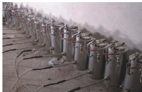
Rys. 3. Odtwarzanie izolacji poziomych metodą termohermetyczną woskami naftowymi.
