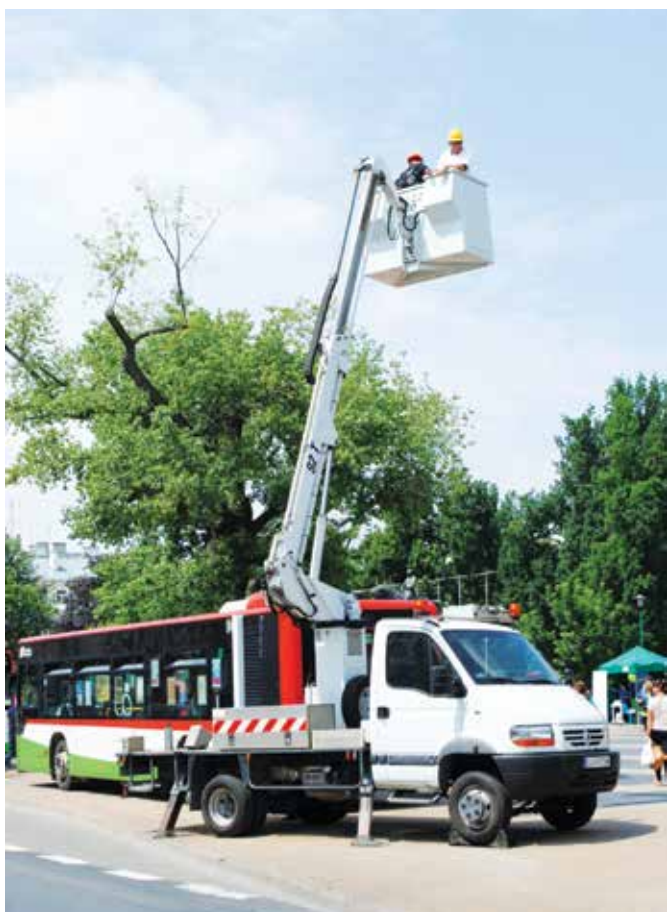
Fot. 21. Iveco należące do MPK w Lublinie wyposażone w podnośnik koszowy na ramieniu do prac sieciowych. Fot. M. Zyśko
