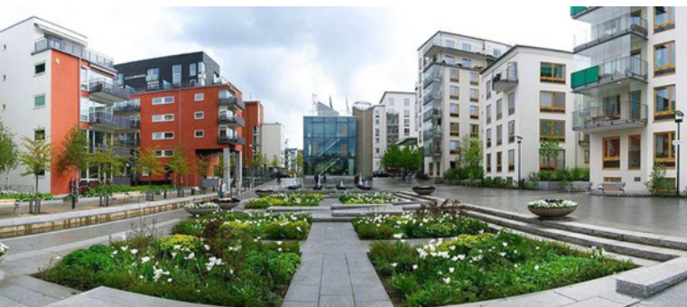
Ryc. 1. Park na osiedlu Hammarby Sjöstad; fot: Hans Kylberg, źródło: https://pl.wikipedia.org/wiki/Plik:Hammarby_Sjostad.jpg , (CC BY 2.0), [dostęp: 21.03.2019]
