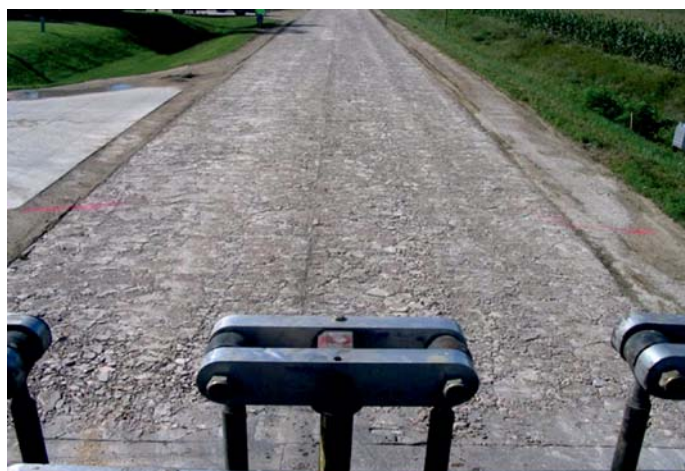
Fot. 13. Powierzchnia pasa nawierzchni betonowej po zawałowaniu walcem okrętowym
