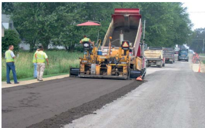
Fot. 19. Pośrednia warstwa podbudowy z destruktu asfaltowego (RAP) układana na płycie betonowej poddanej zabiegowi typu rubblizing zmodyfikowany
