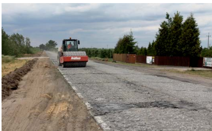
Fot. 6. Walec kratowy o masie 9 ton wyposażony w bandaż typu Z, do powierzchniowego rozkruszania powstałych brył betonu oraz wstępne profilowania powstałego destruktu i jego zagęszczenia [3]
