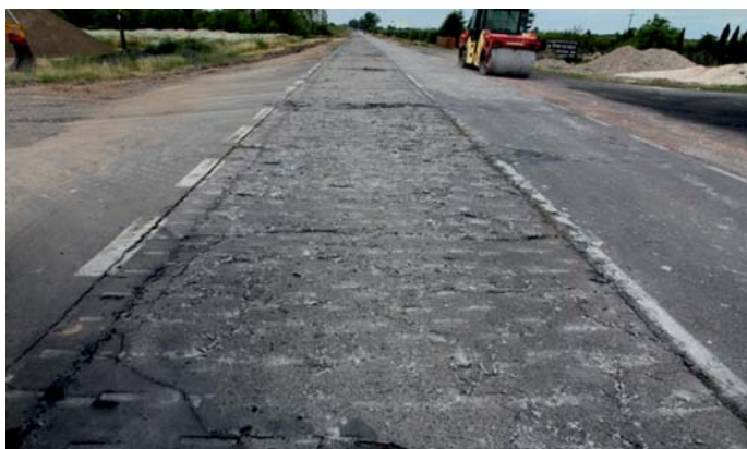
Fot. 5. Pokruszony i odprężony pas płyt betonowych drogi nr 801 po użyciu łamacza do betonu MHB T8600 [3]
