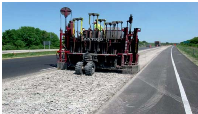
Fot. 8. Kruszenie pasa nawierzchni w sąsiedztwie poprzednio pokruszonego i przykrytego nakładką asfaltową, stosując rubblizing pełny
