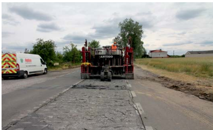
Fot. 4. Specjalistyczny, samojezdny wielogłowicowy (wielomotowy) łamacz do betonu MHB T8600 w trakcie kruszenia nawierzchni betonowej na drodze nr 801 (14.06.2016 r.) [3]
