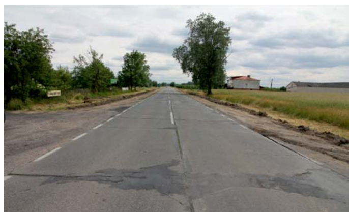
Fot. 3. Droga wojewódzka nr 801 w okolicy miejscowości Wilga – stan sprzed wykonania kruszenia udarowego nawierzchni (czerwiec 2016) [3]
