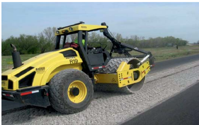
Fot. 9. Walec z kratą typu Z kończący rozdrabnianie pokruszonych kawałków betonu oraz wygładzający powierzchnię i zagęszczający materiał warstwy
