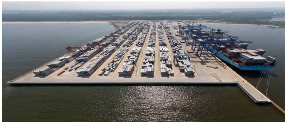
Rys. 1. Morski terminal przeładunkowy w Gdańsku
