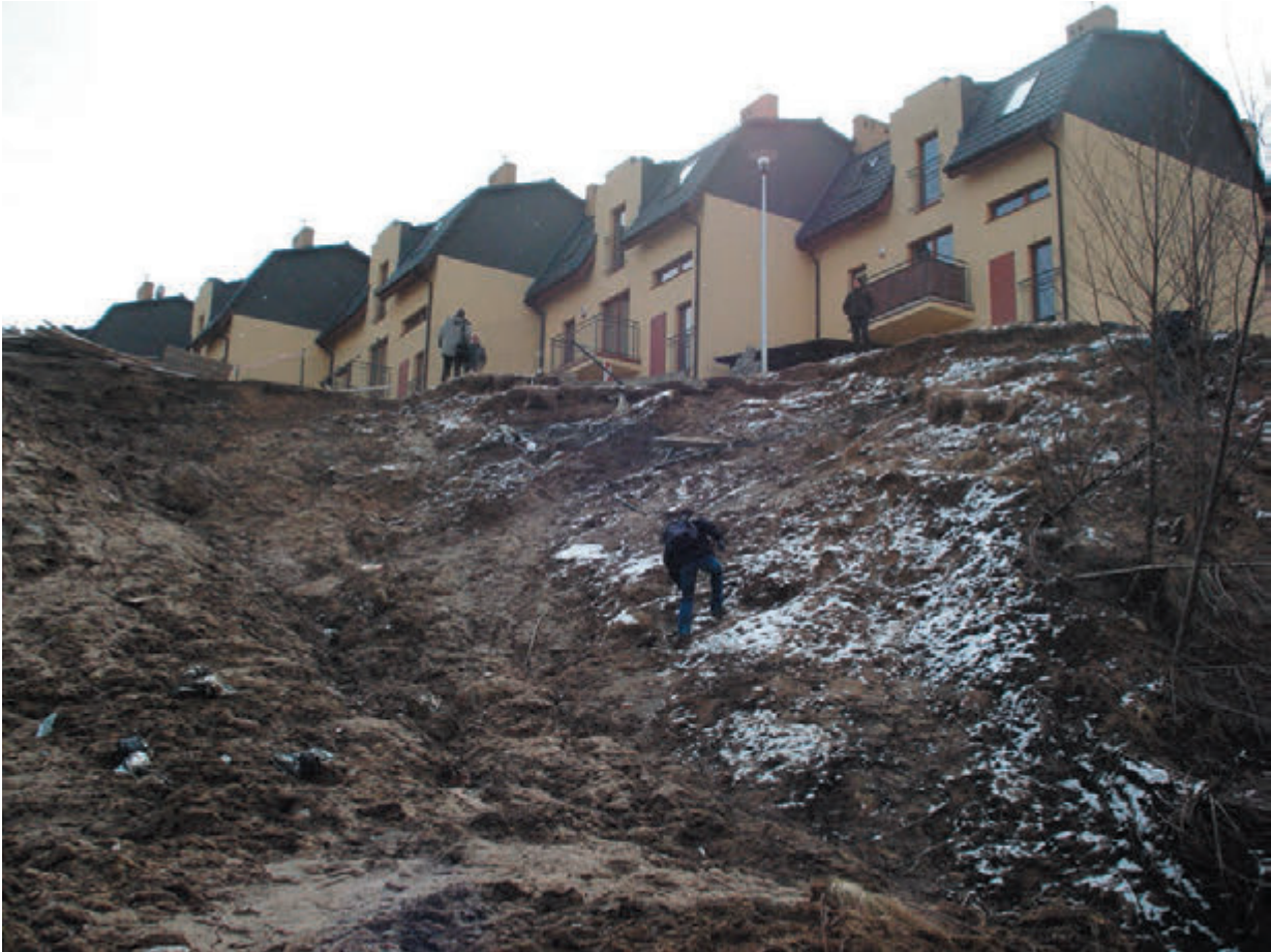
Rys. 3. Widok osuwiska bezpośrednio zagrażającego zabudowie mieszkalnej (fot. J. Frydel) Fig. 3. A view of the landslide directly threatening the residential quarters (photo J. Frydel)
