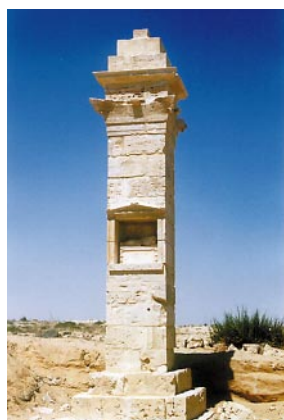
Ryc. 12. Marina El-Alamein. Filarowy pomnik nagrobny T1K po anastylozie i konserwacji (fot. autor)
