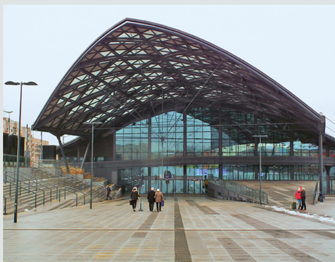
Fot. 15. Dach stacji kolejowej Łódź Fabryczna, źródło: Wikimedia Commons
