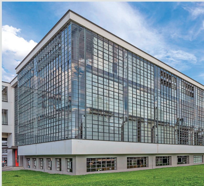
Fot. 5. Ściana kurtynowa w budynku Bauhausu w Dessau, źródło: Wikimedia Commons
