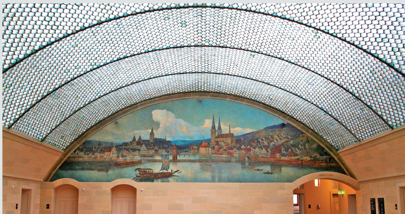
Fot. 2. Strop ze szklanych pustaków Falconniera w Ratuszu w Zurychu, źródło: Wikimedia Commons
