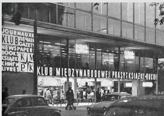
Fot. 6. Ściana kurtynowa Klubu Międzynarodowej Prasy i Książki na Ścianie Wschodniej (Domy Towarowe Centrum) w Warszawie, źródło: Wikimedia Commons
