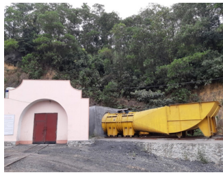
Fig. 5. The shape of the main fans stations in Giap Khau mine Rys. 5. Głównych stacje wentylatorów w kopalni Giap Khau
