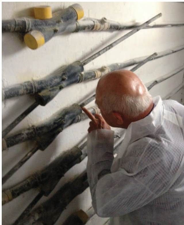
Rys. 6. Monitorowanie systemu sprężenia wzmocnionego silosu na cukier i pomiary poślizgów cięgien
