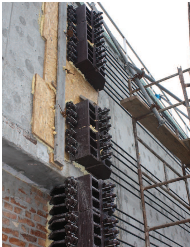
Rys. 7. Sposób wzmocnienia ścian żelbetowych komór zgarniaczy osadnika wstępnego
