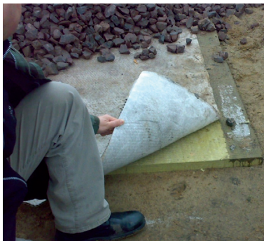
Rys. 2. Układanie podtłuczniowej maty z wełny mineralnej typu Rock Ballast
