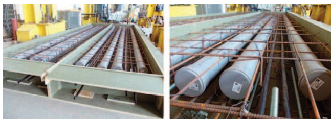
Rys. 6. Płyty „kanalowe” pomostu wagi przed zabetonowaniem
