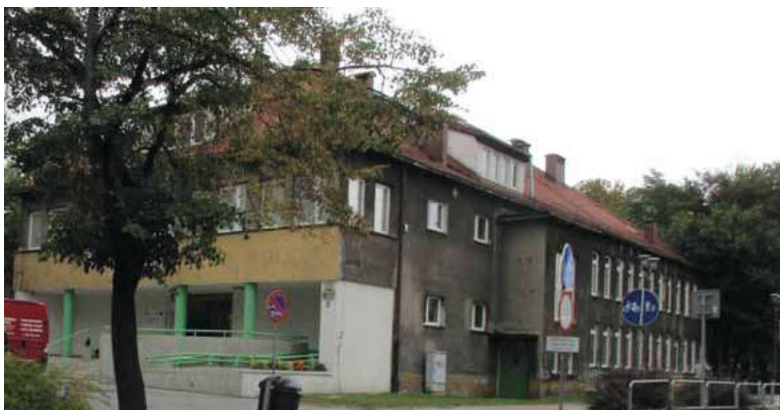
Rys. 2. Budynek Żłobka Miejskiego w Katowicach przy ul. Uniwersyteckiej 15 – widok ogólny od strony południowej Fig. 2. City Nursery in Katowice at 15 Uniwersytecka Street – general view from the south
