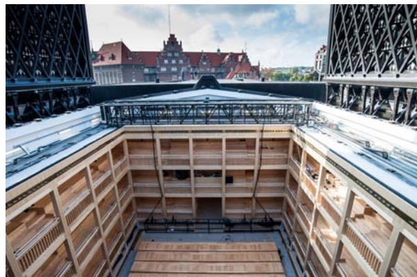
Ryc. 2. Otwierany dach został usytuowany ponad widownią, www.sztuka-architektury.pl
