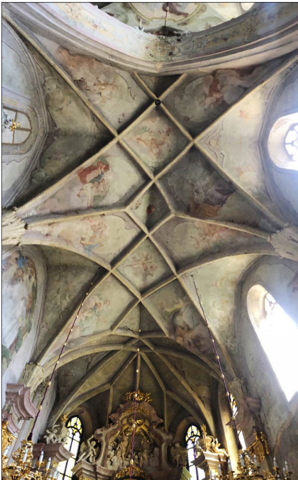
Ryc. 8. Kościół św. Bartłomieja, sklepienie prezbiterium; fot. autor. Fig. 8. St. Bartholomew's Church, the vault in the chancel; photo by the author.
