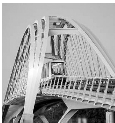
Fot. 1. Automatyczne metro VAL przecinające drogę szybkiego ruchu
