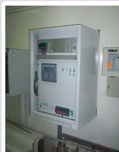
Rys. 2. Mikroprocesorowy elektrohydrauliczny regulator mocy (MREH) konstrukcji OTC
