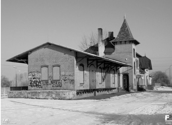
Rys. 4. Zdewastowany budynek dworcowy - Jelenia Góra Sobieszów (stan na 2011 rok – zbliżony do stanu aktualnego)
