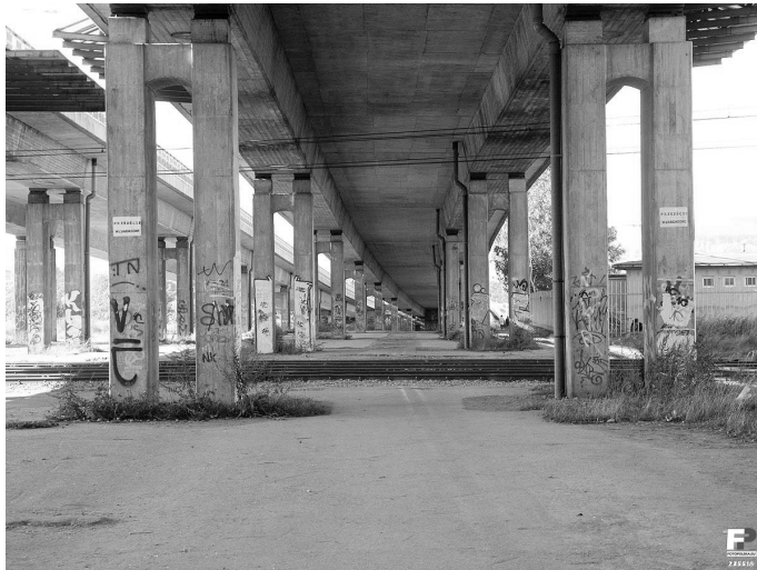
Rys. 5. Estakada nad torami w ciągu al. Jana Pawła II, planowane miejsce powstania nowego przystanku pasażerskiego (źródło: http://jelenia_gora.fotopolska.eu/Jelenia_Gora/b51644,Estakada_nad_torami.html?f=235518-foto , dostęp 16.11.2015r.)
