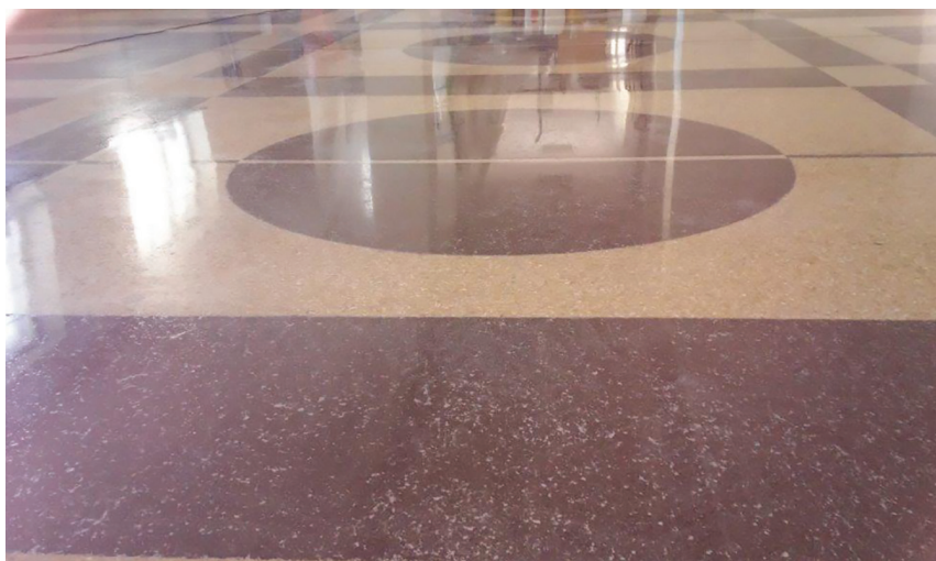
Fot. 3. Posadzka typu lastrico po rewitalizacji z widocznym efektem wybliszczenia po polerowaniu [M1]
