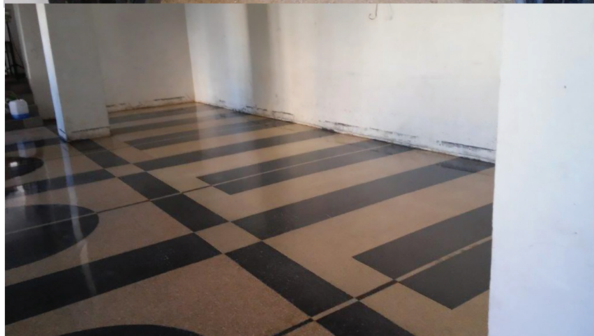
Fot. 2. Posadzka typu lastrico po rewitalizacji w miejscach odtwarzanych [M1]
