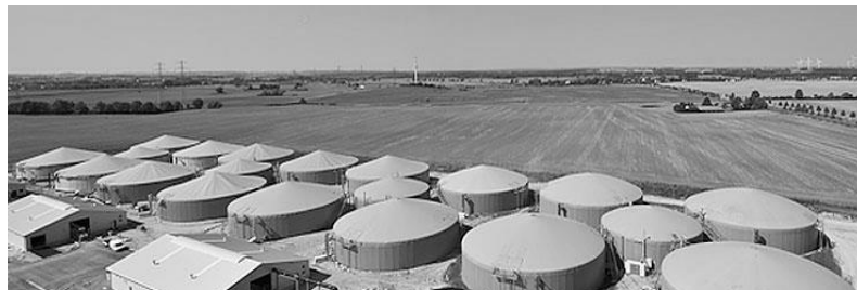
Fig. 3 Bioenergiepark Güstrow – 20 digesters with a capacity of 50 MWth (Quelle: NAWARO Bioenergie AG)
