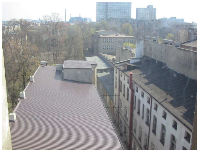
Fot.1 Widok z góry na kompleks budynków mieszkalnych z placem wewnętrznym typu studnia
