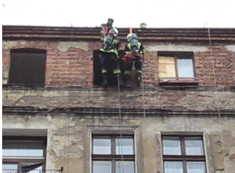
Fot. 8 Wycinanie krat na 4 piętrze budynku.
