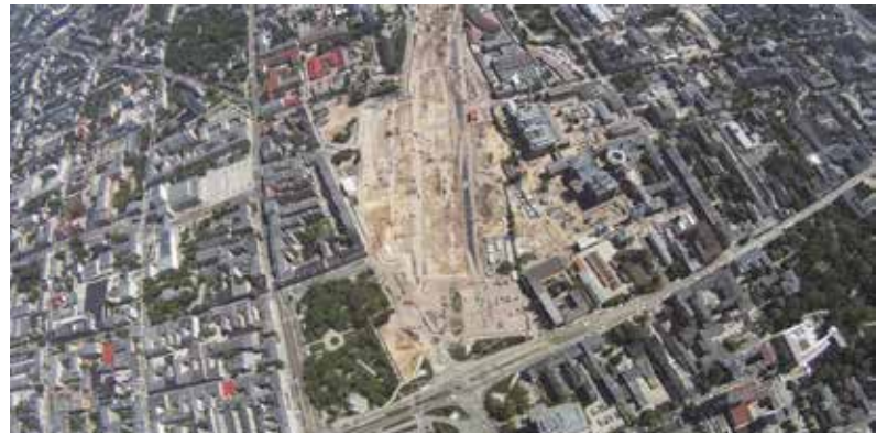
Fot. 5. Wykop na głębokość – 8 m pod budowę dworca Łódź Fabryczna
