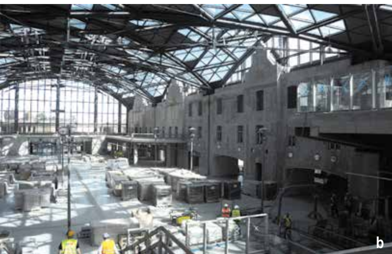
Fot. 1. Zdjęcie budynku dworca Łódź Fabryczna: a) z 1868 r. [Internet], b) nawiązanie do konstrukcji elementów starej elewacji w budowlu dworca 2016. [fot. autora].
