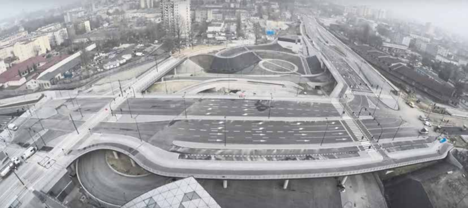
Fot. 10. Węzeł komunikacyjny po stronie wschodniej dworca Łódź Fabryczna Źródło: Archiwum Torpol.
