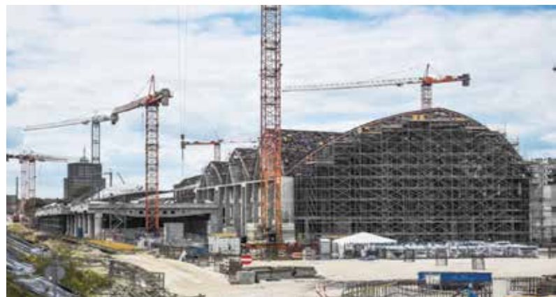
Fot. 7. Etap budowy dworca Łódź Fabryczna w maju 2015
