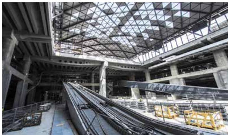
Fot. 9. Etap budowy dworca Łódź Fabryczna w październiku. Fot. A. Giedryś.
