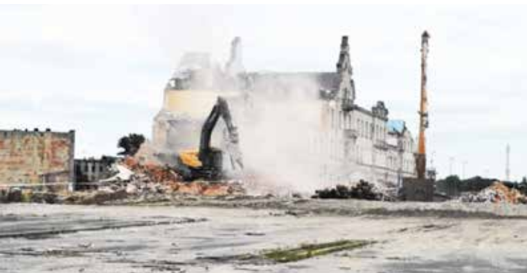
Fot. 4. Wyburzenie budynków starego dworca Łódź Fabryczna
