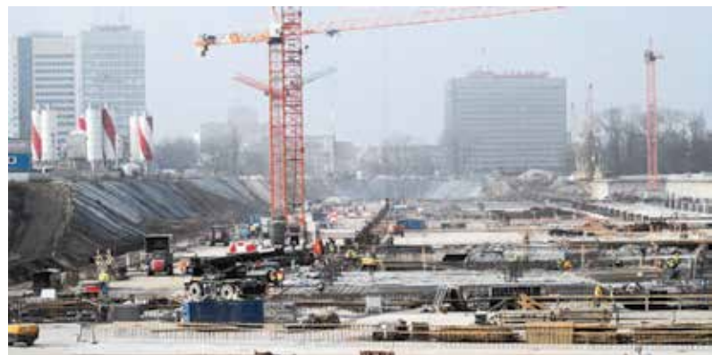
Fot. 6. Budowa stropu dworca na poziomie -8 m, listopad 2013 r.
