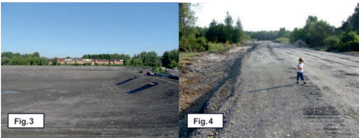
Rys. 3. Budowa osadników wód dołowych ZG Janina z zastosowaniem kruszywa TAURON Wydobycie S.A. (materiały TAURON Wydobycie S.A., fot. K. Paw)
