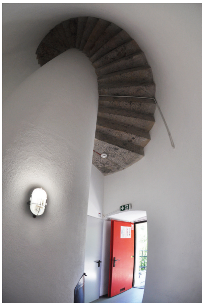
Rys. 7. Wnętrze latarni morskiej Rozewie II, od lewej: strefa wejściowa, schody drabinowe prowadzące na galerię, odprowadzenie skroplin; źródło: fot. Agnieszka Pluszczewicz
