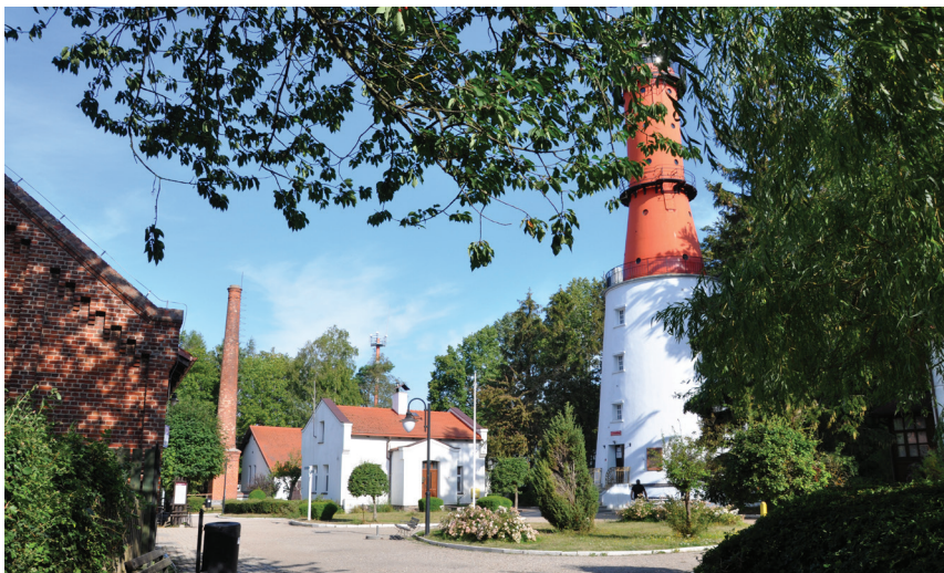
Rys. 3. Kompleks zabudowań latarni morskiej Rozewie I; źródło: fot. Agnieszka Pluszczewicz
