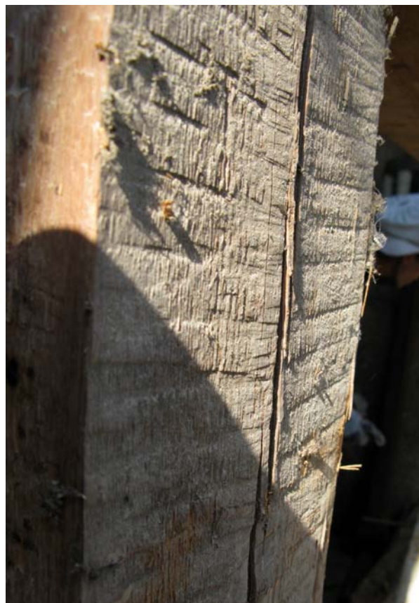
Ryc. 3. Powierzchnia belki ze śladami po obróbce ręczną piłą tracką. Wiatrak z Woli Koryckiej z ok. 1870 r.
