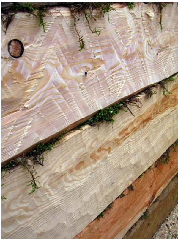
Ryc. 2. Przykłady obróbki powierzchni drewna ścian wieńcowych różnymi narzędziami. Topór zwykły (bal górny), cieślca (bal dolny). Tokarnia 2011 Fig. 2. Examples of surface finish of a log wall: axe (upper log), adze (bottom log). Tokarnia 2011
