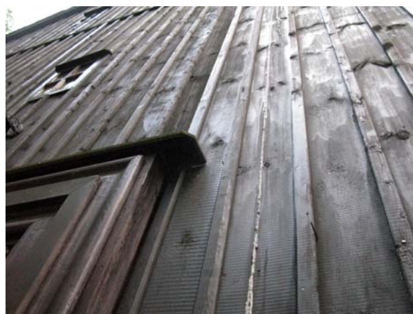
Ryc. 4. Nowe szalunki w kościele z XVII w. w Gąsawie. Widoczne ślady maszynowej obróbki desek szalunkowych
