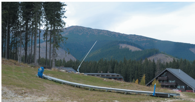
Fot. 6. Chodnik ruchomy w okresie poza eksploatacją [fot. P. Murzyn]
