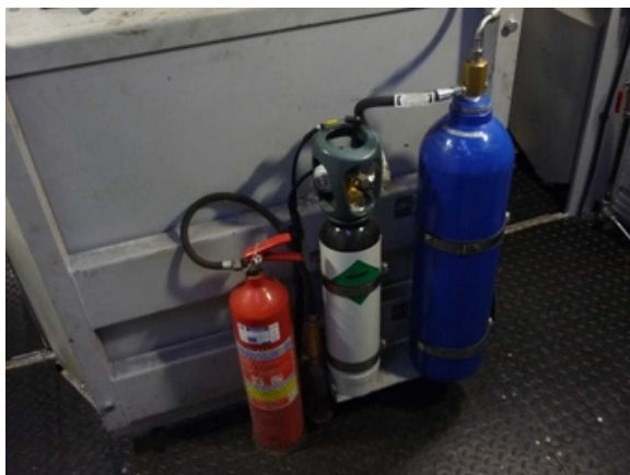
Rys.5 Zabudowa butli ze środkiem gaśniczym Tempa S30 i azotem w zmodernizowanych lokomotywach SM42-6Dk(a), ST45-301Dd(b) i ST46-303Da(c)
