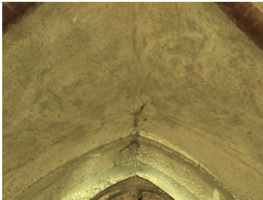
Rysunek 1. Chmura punktów – rysa nad wejściem
