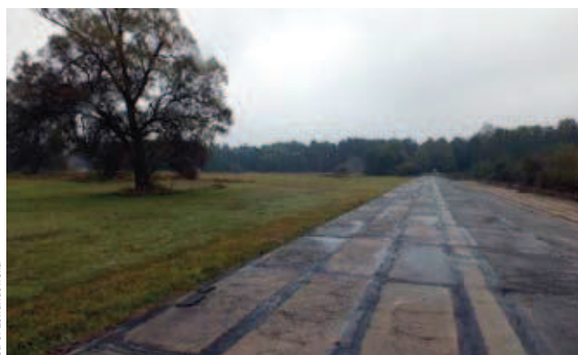
Rys. 2. Górny przelew wałowy polderu Golina w miejscowości Kraśnica – widok od strony północnej
