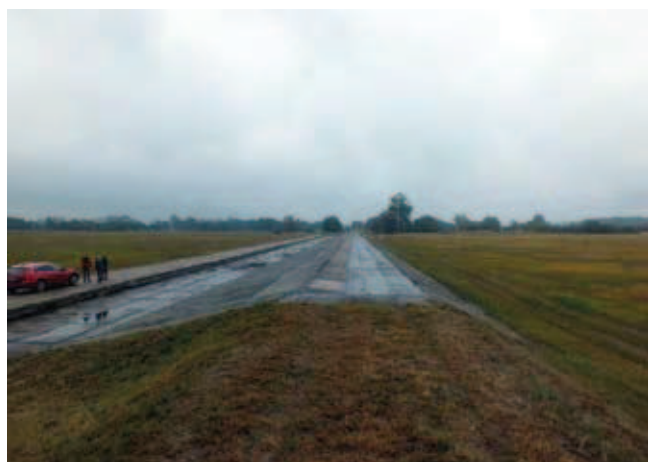
Rys. 3. Dolny przelew wałowy polderu Golina – widok od strony południowo-zachodniej
