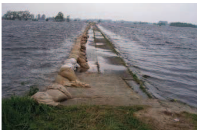
Rys. 6. Dolny przelew wałowy polderu Golina w trakcie przejścia fali powodziowej w 2010 roku (fot. A. Mallinger 27 maja 2010 roku)
