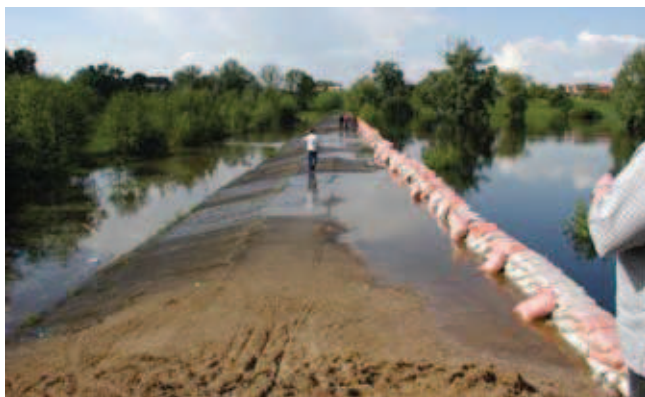
Rys. 5. Górny przelew wałowy polderu Golina w Kraśnicy w trakcie przejścia fali powodziowej w 2010 roku (fot. Z. Sroka 22 maja 2010 roku)
