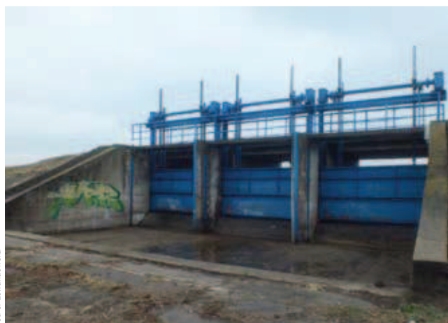
Rys. 4. Jaz upustowy polderu Golina – widok od strony północno-zachodniej
